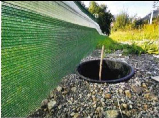
Abbildung 2. Das blickdichte Raschelgewirke ist am oberen Rand beidseitig mit einer Folienfahne versehen, um Tieren, die das Gewebe erklettern, das Überwinden des Zaunes unmöglich zu machen.
